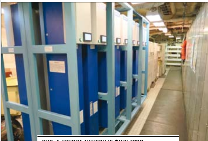
РИС. 4. ГРУППА АКТИВНЫХ ФИЛЬТРОВ, РАБОТАЮЩАЯ С ПРИВОДАМИ БУРОВЫХ НАСОСОВ
