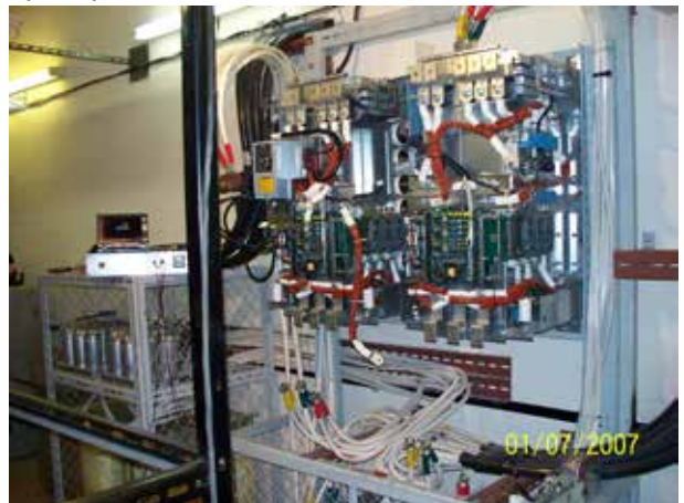
Ремонт синусоидального фильтра преобразователя частоты «Vacon»
