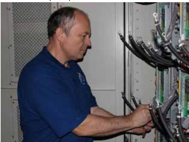
Ремонт высоковольтного преобразователя частоты «ТМЕIC»
