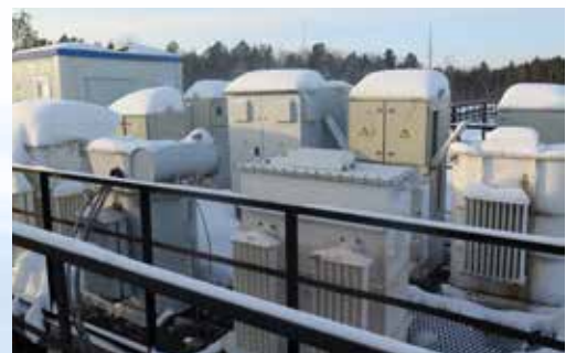
Пример. Электроприводы погружных насосов нефтяных месторождений
