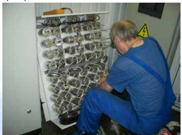
Ремонт синусоидального фильтра преобразователя частоты «Веспер»
