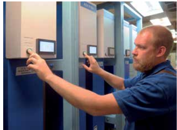
Наладка активных фильтров на буровой платформе
