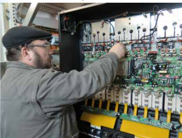
Ремонт преобразователя частоты «Веспер» мощностью 1 МВт на пункте сдачи-приёмки нефтепродуктов
