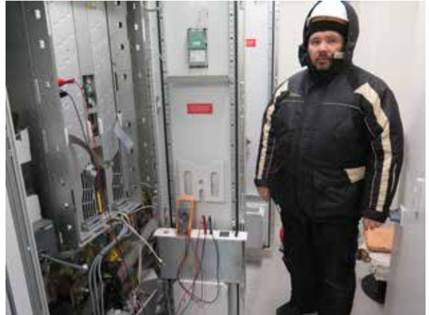
Формовка конденсаторов звена постоянного тока преобразователя частоты «Emotron»
