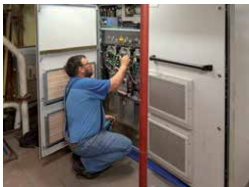
Наладка преобразователя частоты системы «Валогенератор» (690 В, 1000 А)
