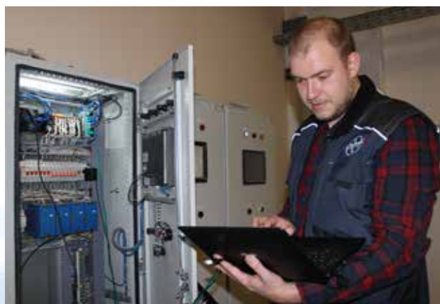
Наладка высоковольтной системы частотного регулирования тяго-дутьевых машин котла.
