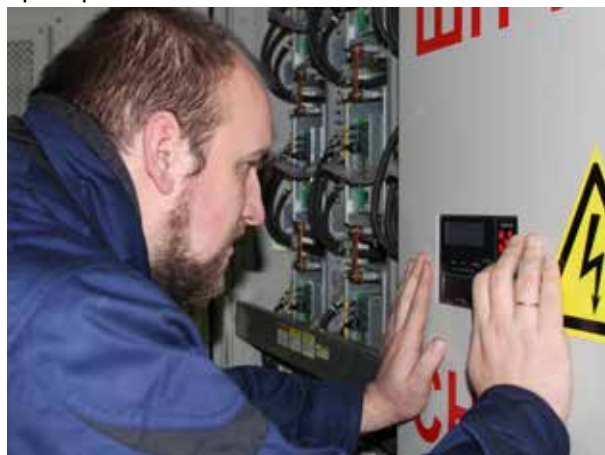
Индивидуальные испытания преобразователя частоты «ТМЕIC» после ремонта
