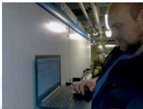
Наладка параллельной работы установки «Валогенератор» и дизельной электростанции
