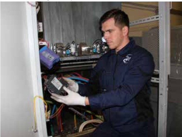
Полная разборка и ремонт преобразователя частоты «Vacon» мощностью 630 кВт
