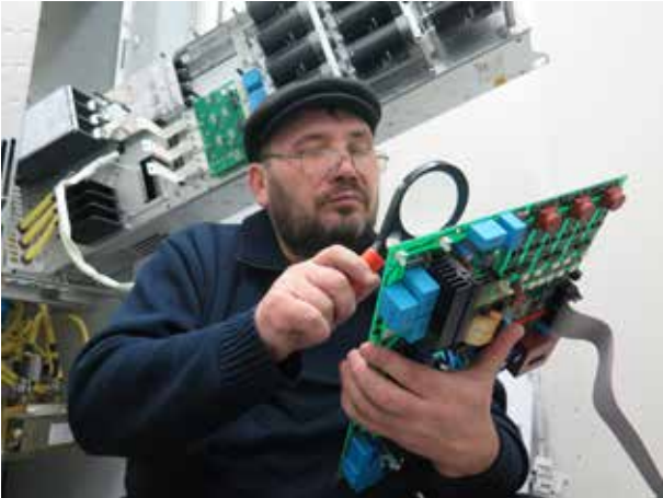
Ремонт преобразователя «Emotron» мощностью 710 кВт на мультифазной насосной станции
