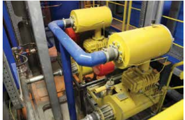
Пример – электроприводы компрессоров барьерного воздуха газоперекачивающих агрегатов
