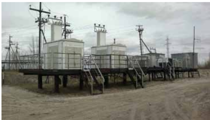
Пример – электроприводы погружных насосов нефтяных месторождений
