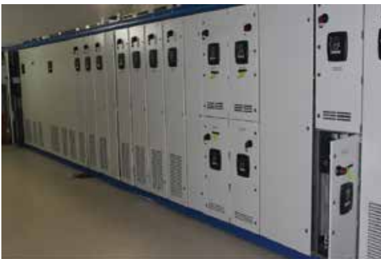
Пример – электроприводы бумагоделательных машин
