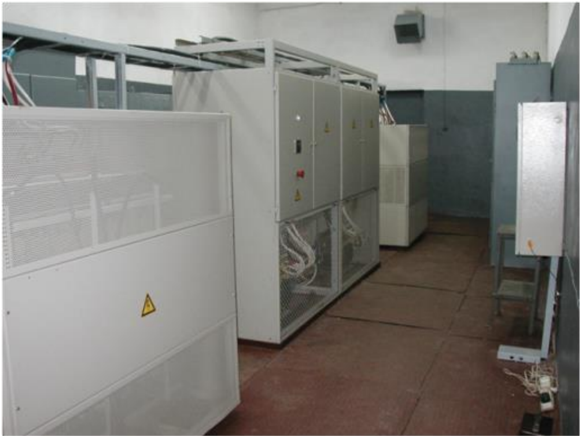
Преобразователь частоты Vacon CX в «двухтрансформаторной» схеме включения (система 630 кВт, 6 кВ).
