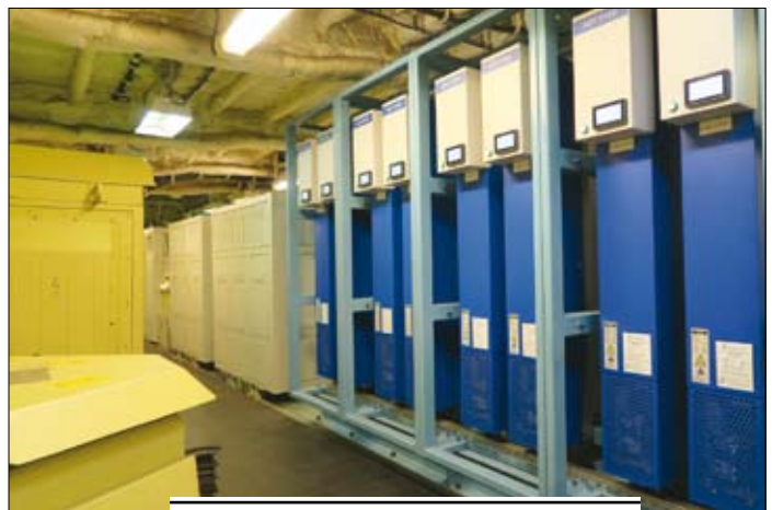
РИС. 5. ГРУППА АКТИВНЫХ ФИЛЬТРОВ, РАБОТАЮЩАЯ С ПРИВОДАМИ ЛЕБЕДКИ И СВП
