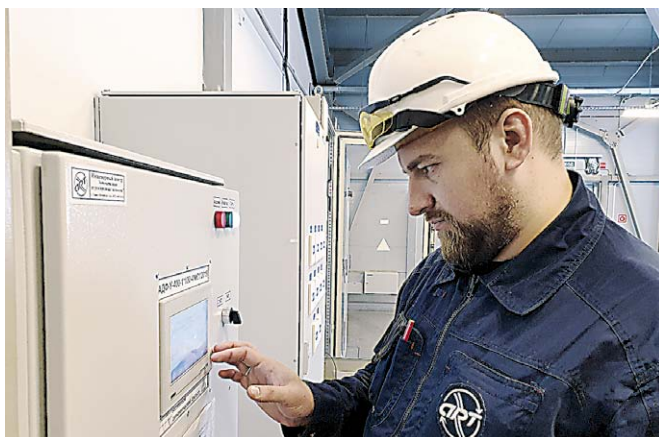
Активный фильтр для компенсации высших гармоник, поступающих со стороны источника электроэнергии
